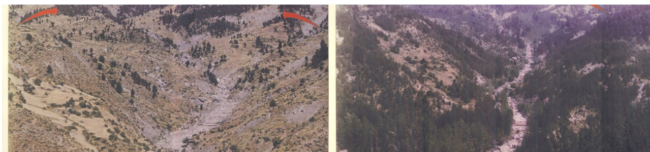
Evolución de las obras de corrección torrencial en el barranco de Metsovitikos: del estado inicial al restaurado. © cortesía de Secretaría General de Bosques y Medio Natural de Grecia.
