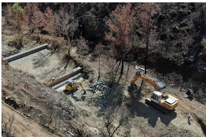
Obras de retención con gaviones en cauces afectados por el incendio de Arakapas. Kostas Aristeidou, © cortesía de Ministerio de Agricultura, Desarrollo Rural y Medio Ambiente de Chipre.
