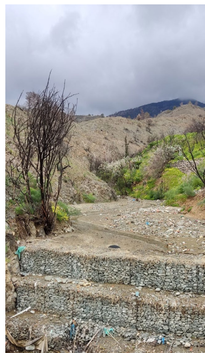
Acumulación de materiales en presa de gaviones procedentes de la parte alta de la cuenca. Kostas Aristeidou, © cortesía de Ministerio de Agricultura, Desarrollo Rural y Medio Ambiente de Chipre.
