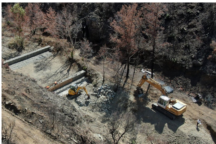
Obres de retenció amb gabions en lleres afectades per l'incendi d'Arakapas. Kostas Aristeidou, © cortesia de Ministeri d'Agricultura, Desenvolupament Rural i Medi Ambient de Xipre.
