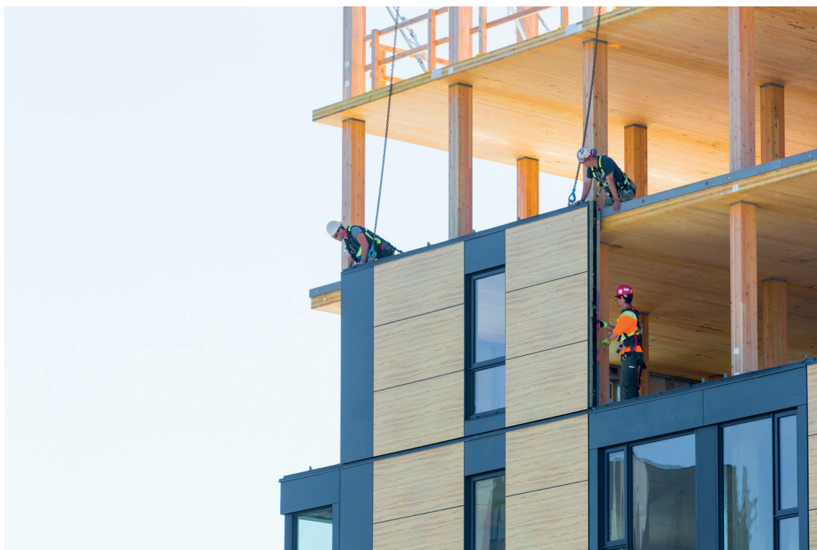
图 6。在温哥华（UBC）建造 Brock Commons 学生宿舍，这是世界上最高的交叉层压木材（CLT）建筑，高 53 米。在许多国家，建筑法规仍然根据过时的法规限制木材建筑的高度。图片来源： https://www.naturallywood.com/
