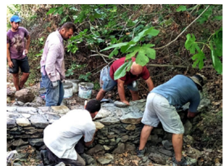
Construcció d'una micropresa al barranc de Karavas (Citera), gràcies a la participació de veïns de la comunitat. @Zafeiriou © MedINA (Mediterranean Institute for Nature and Anthropos)
