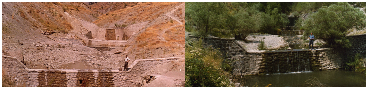
Evolució de les obres de correcció torrencial al barranc de Metsovitikos: de l'estat inicial al restaurat. © cortesia de la Secretaria General de Boscos i Medi Natural de Grècia
