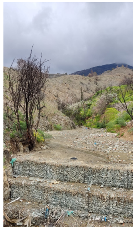
Acumulació de materials a la presa de gabions provinents de la part alta de la conca. Kostas Aristeidou, © cortesia de Ministeri d'Agricultura, Desenvolupament Rural i Medi Ambient de Xipre.
