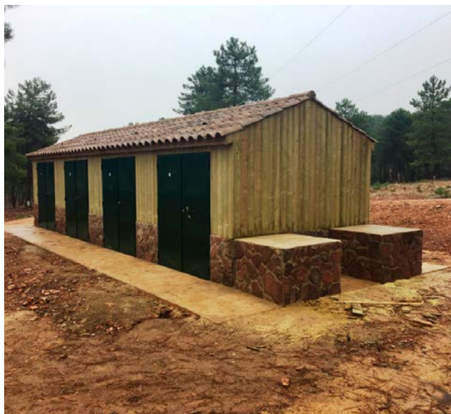
Foto 9. Almacén de servicio para herramientas y equipos de resineros.
